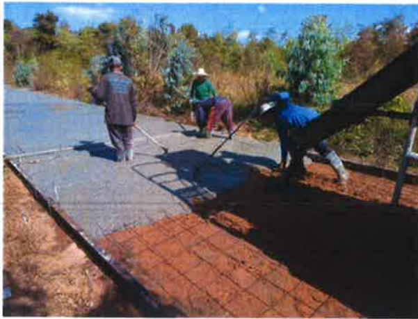
๔.โครงการก่อสร้างถนนคอนกรีตเสริมเหล็ก หมู่ที่ ๑ เส้นไปเมรุ ต่อจาก ถนน คสล. เดิม
