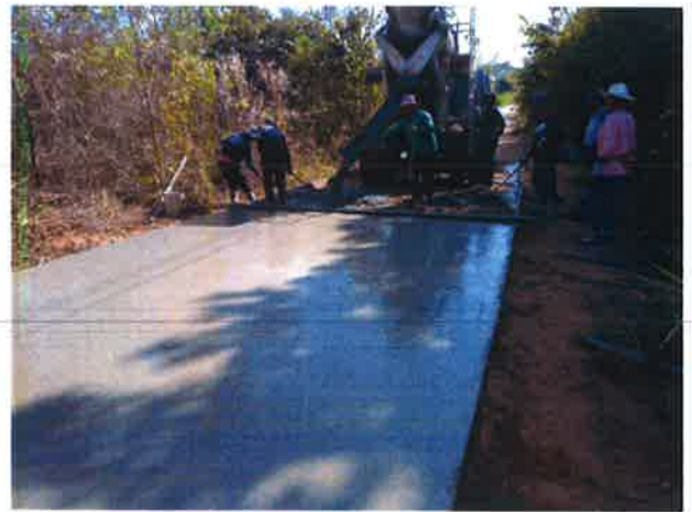
๕. โครงการก่อสร้างถนนคอนกรีตเสริมเหล็ก หมู่ที่ ๕ เส้นบ้านนายอนันต์ ไปเขตไฟฟ้า
