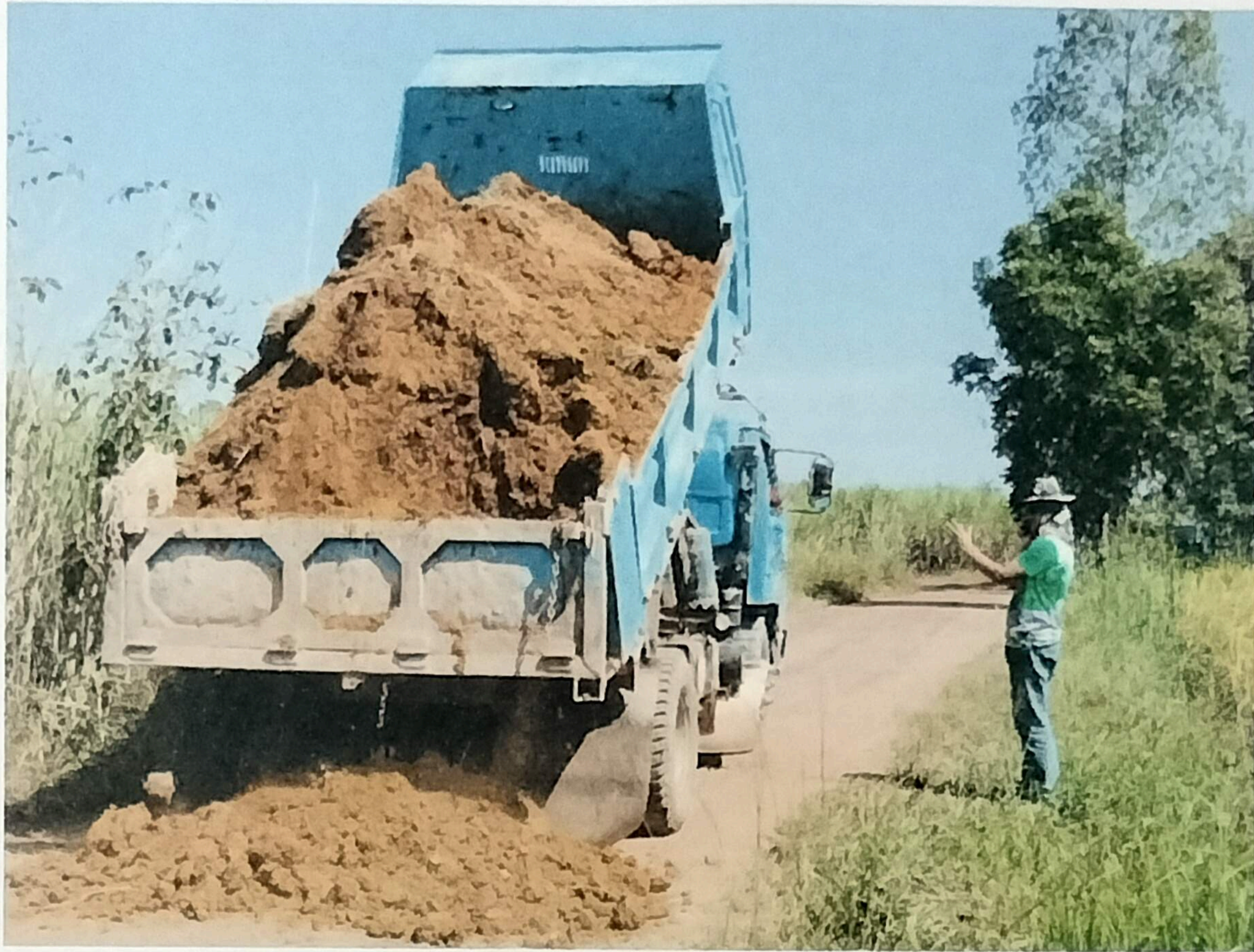
ภาพขณะดำเนินการซ่อมแซม
